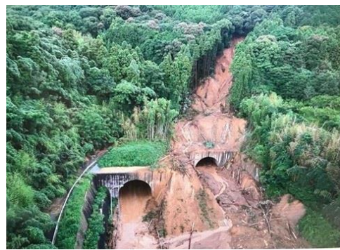
災害復旧現場
