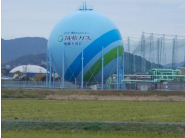
【筑紫ガス ガスタンク 写真協力：写楽の会 天野繁君】
